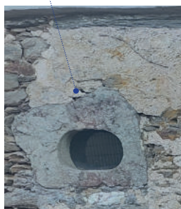
Corniche en dalles de schistes puis en gênoise de briques
