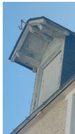
Pannes à abouts moulurés «en sifflet»
