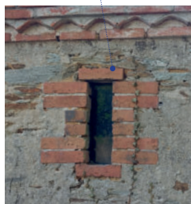
Corniche en dalles de schistes puis en gênoise de briques
