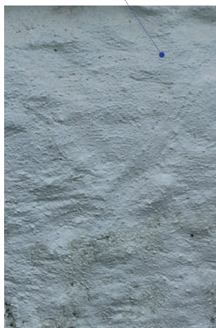
Enduit chaulé (recouvert de chaux blanche)
