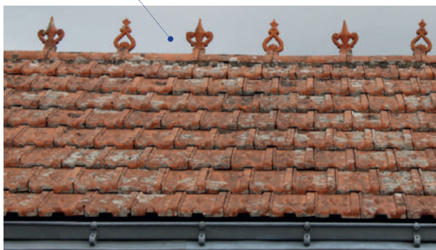
Tuiles à emboîtement dites «mécaniques» et faitage décoratif
