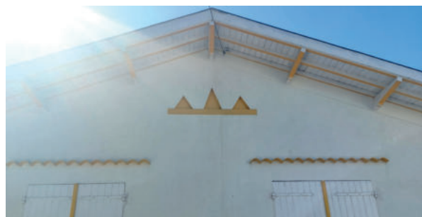
Tuiles à emboîtement dites «mécaniques» et faitage décoratif
