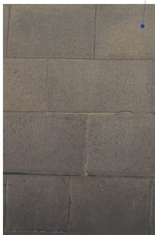
Parement de pierre de taille «dure», destiné à habiller les soubassements
