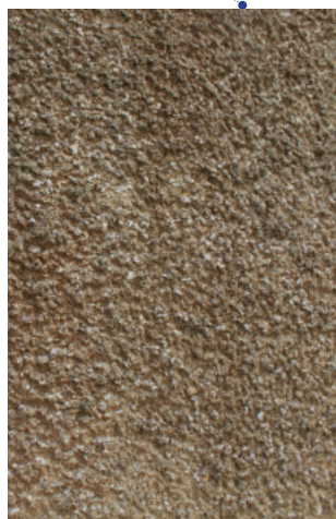
Enduit au ciment à mouchetis, également dit «à la tyrolienne»
