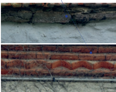
Corniche en dalles de schistes puis en gênoise de briques
