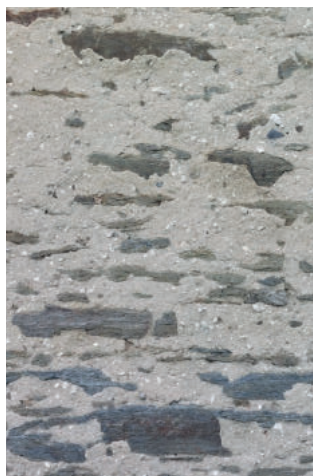
Enduit affleurant à pierres vues, avec pétard de chaux et mignonnette (gros grain)
