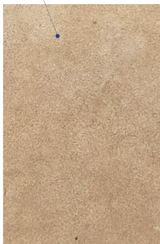
Enduit au mortier bâtard (ciment, sable et chaux)
