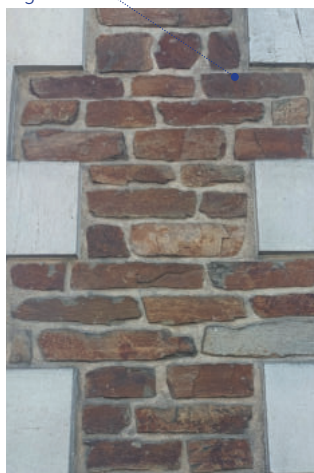
Parement décoratif de pierres imitant des moellons, à assises régulières
